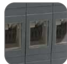
Видимый разрыв за счет окошек на фронтальной части рубильника
